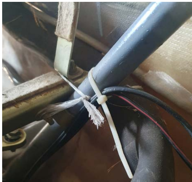
Fot. 4 Na szczęście sznurek do snopowiązałki nie jest już reglamentowany
