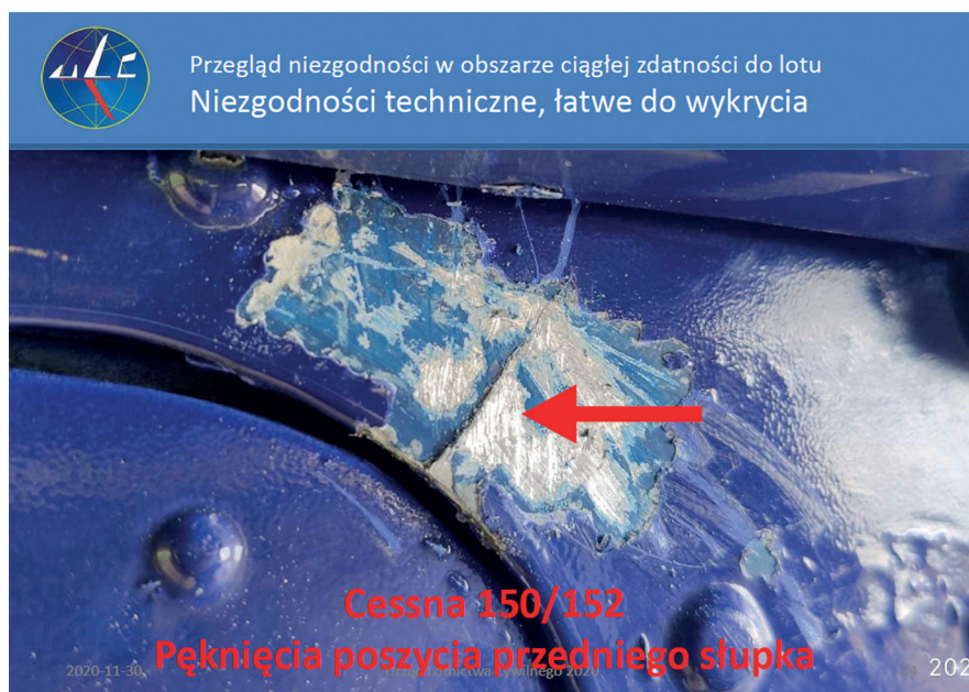
Fot. 5. Pęknięcie poszycia (okolicy węzła przenoszące obciążenia)
