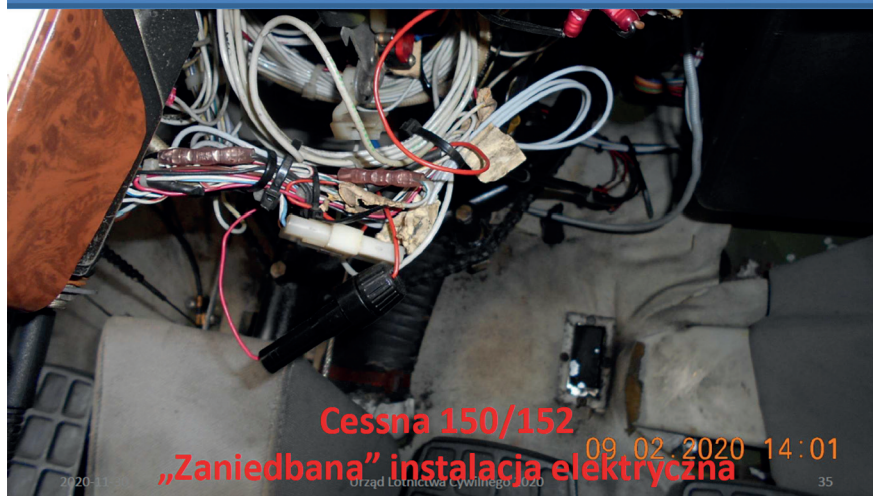
Fot. 7. Wisząca instalacja elektryczna
