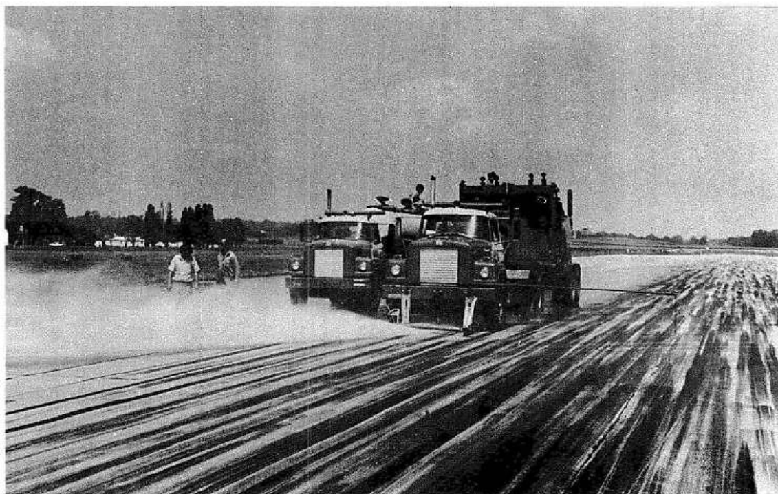
Rycina 4-3. Usuwanie gumy metodą pompy wysokociśnieniowej
