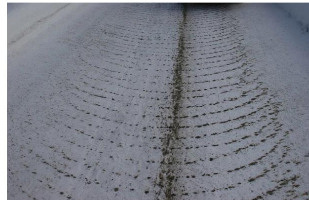
Sposób posypywania nawierzchni na ubitym śniegu
